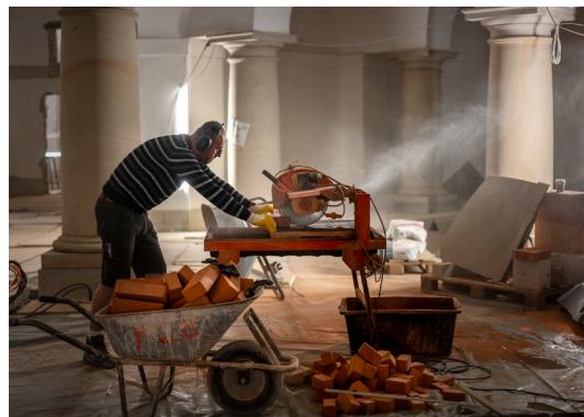
Baustelle der Hohenzollerngruft, Juni 2025 Fotografie: Alexandra Sell, © Alexandra Sell und Berliner Dom
