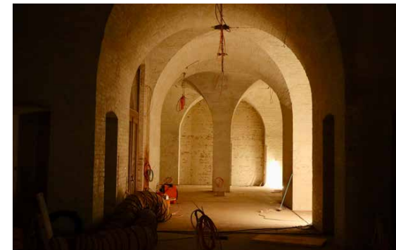
Baustelle der Hohenzollerngruft im Juli 2025
