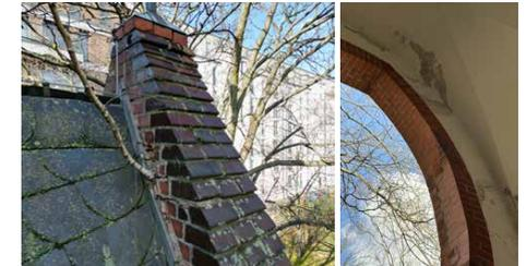
Kapelle, schadhaftes Mauerwerk und Innenraum, schadhafter Putz
