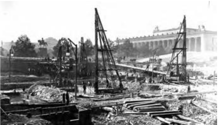
Gründungsarbeiten für den Berliner Dom, ca. 1894
